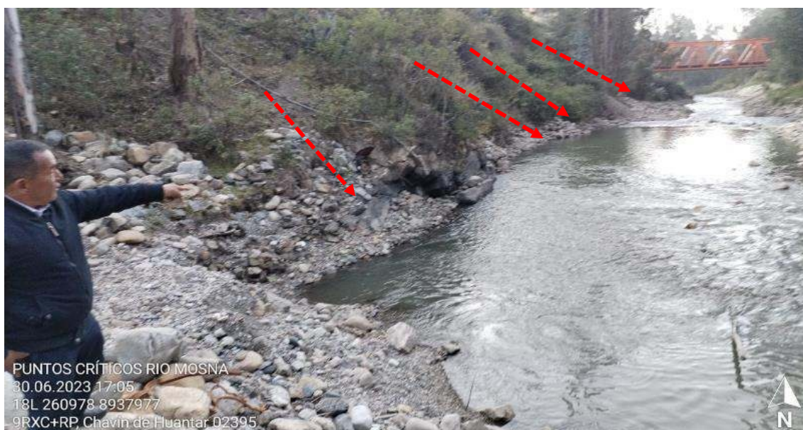
FIGURA N° 02: TRAMO CRITICO POR EROSION EN EL RIO MOSNA, QUE PONE EN PELIGRO LA CARRETERA EN EL SECTOR ULTUPUQUIO, DISTRITO DE CHAVIN DE HUANTAR, PROVINCIA DE HUARI - ANCASH
